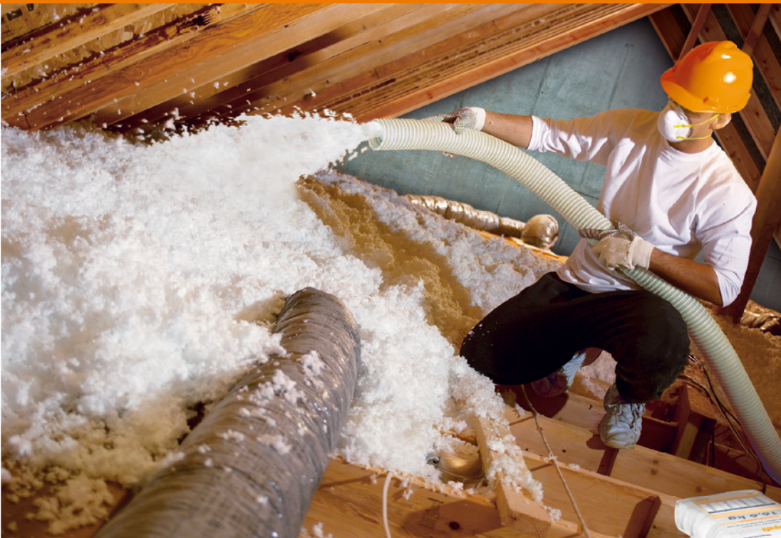
Knauf Insulation Supafil Loft für die Aufblasdämmung in Flachdächern und Obersten Geschoßdecken.
