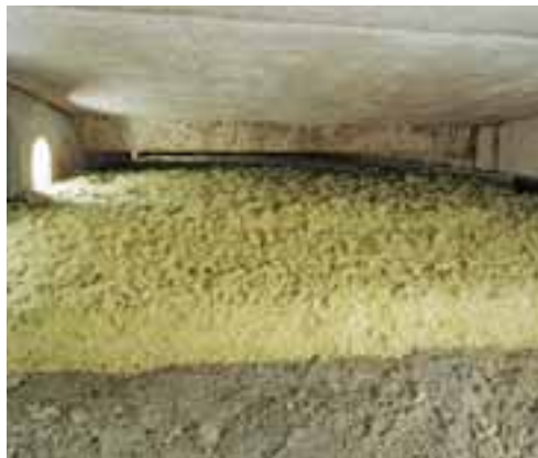
Belüftetes Flachdach mit Rockwool Granulat gedämmt
