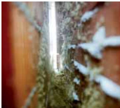
Verfüllung der Trennfuge zwischen Wohngebäuden
