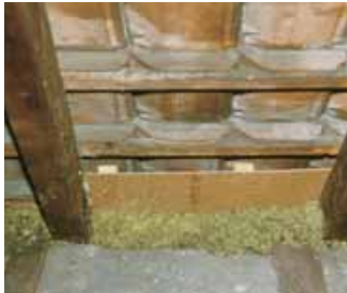
Dachschräge mit Rockwool Granulat gedämmt (mit Hinterlüftung)
