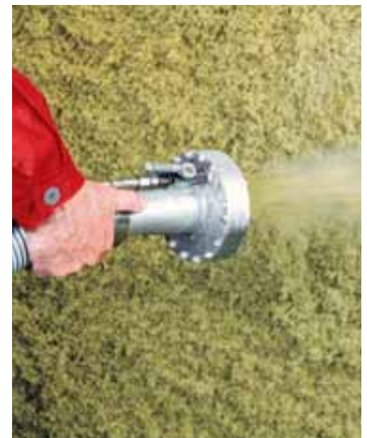
Benetzen der Steinwolle-Flocken mit Sprühkleber
