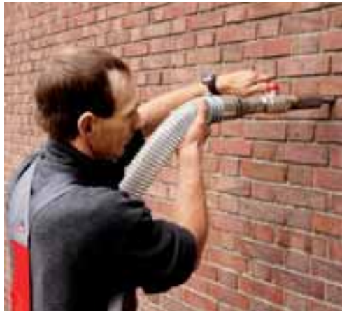
Anbringen einer Kleindüse in einer Kreuzfuge des Mauerwerks
