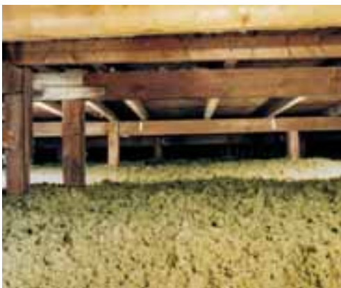
Belüftetes Flachdach gleichmäßig gedämmt
