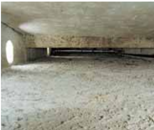
Belüftetes Flachdach vor dem Einblasen des Rockwool Granulates
