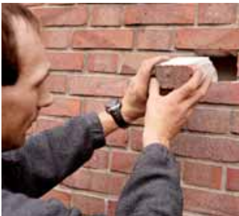
Entfernen eines Steins für die Anbringung einer Großdüse
