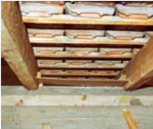
Dachschräge, vorbereitet für das Einblasdämmsystem
