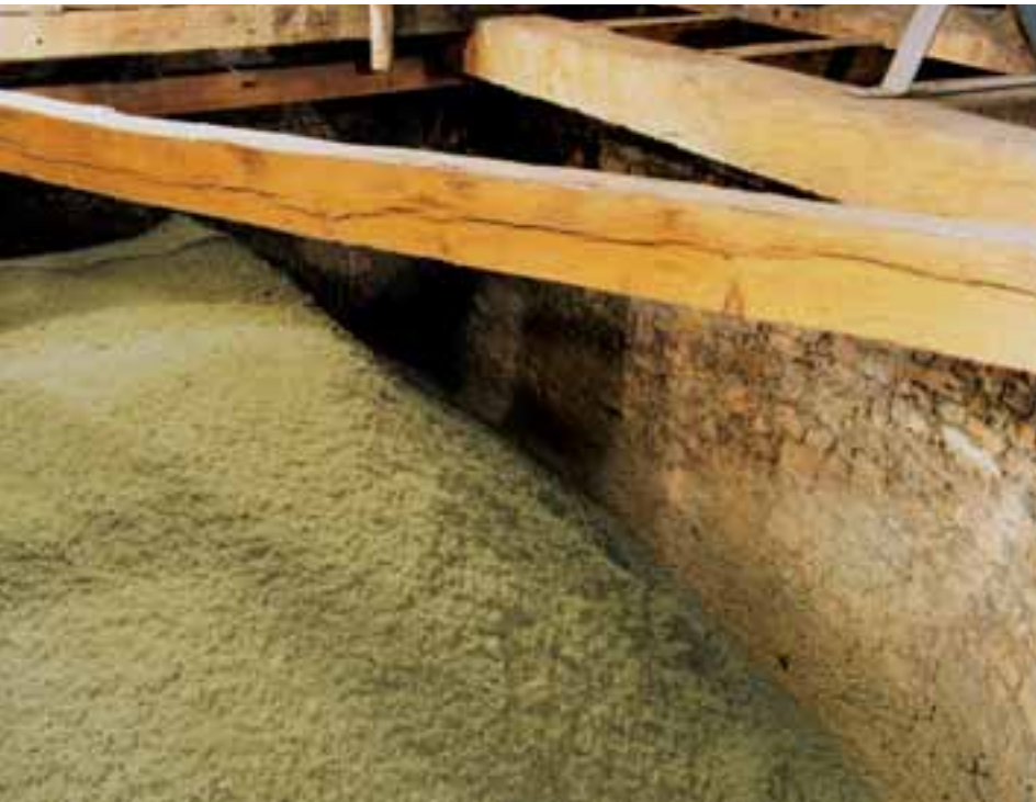
Abrutschsicher aufgebaute Dämmschicht
