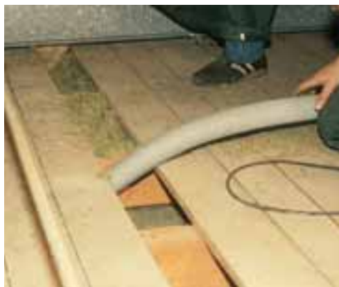
Dämmung einer Holzbalkendecke mit Rockwool Granulat
