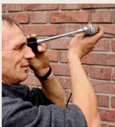
Vor Auftragserteilung wird mittels eines Endoskops überprüft, ob die Außenwand und der Hohlraum zwischen Außen- und Innenwand für die Einblasdämmung geeignet sind.
