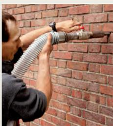
Verläuft diese Überprüfung positiv, werden je nach Beschaffenheit der Wand entweder kleine Löcher in die Kreuzfugen gebohrt oder in Ausnahmefällen einzelne Steine aus dem Mauerwerk entnommen.
