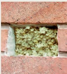
Durch diese Maueröffnungen wird anschließend der Dämmstoff Fillrock KD mittels einer speziellen Druckluftmaschine und flexibler Schlauchverbindungen schnell und sauber in den Hohlraum gefüllt.
